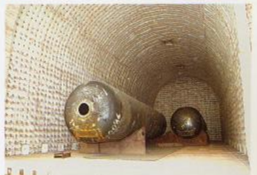
▶ مخازن L.P.G در کوره تنش گیری به ارتفاع ۹ متر، طول ۲۴ متر، عرض ۷/۵ متر
